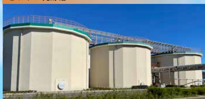
① メタン発酵槽
